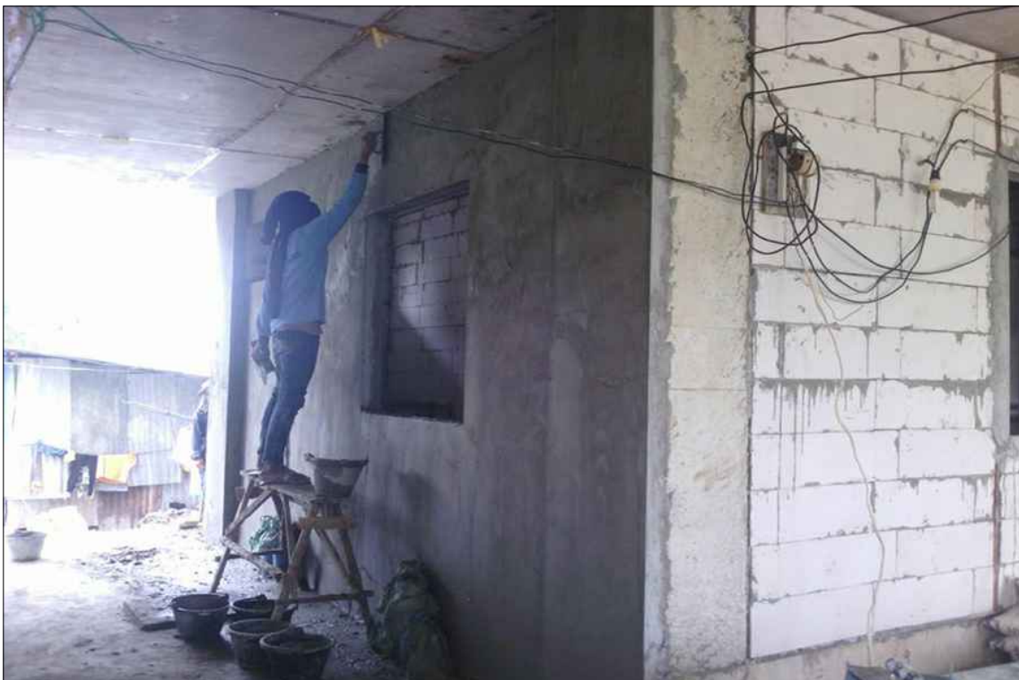
งานก่ออิฐผนังภายในและ ภายนอก
