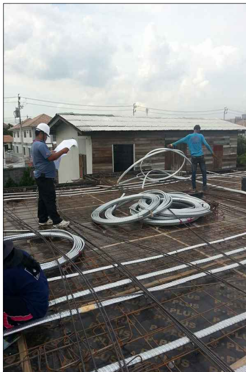
งานโครงสร้างพื้นชั้นที่ 2
