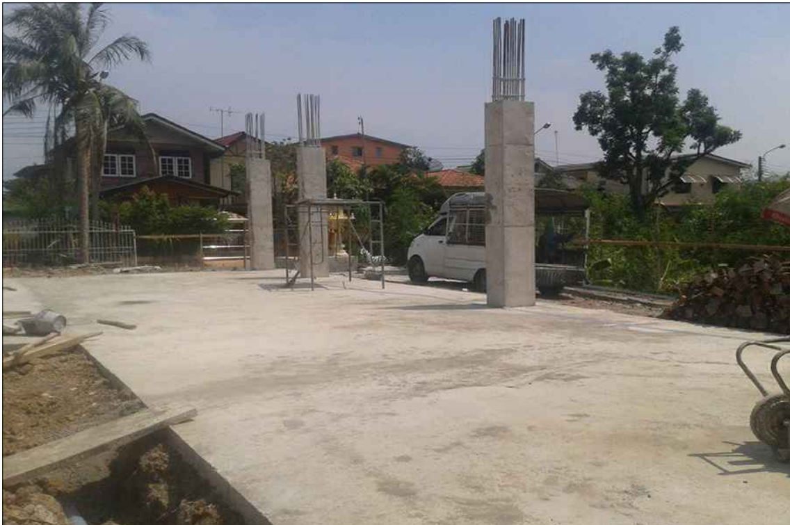
งานโครงสร้างพื้นชั้นที่ 1
