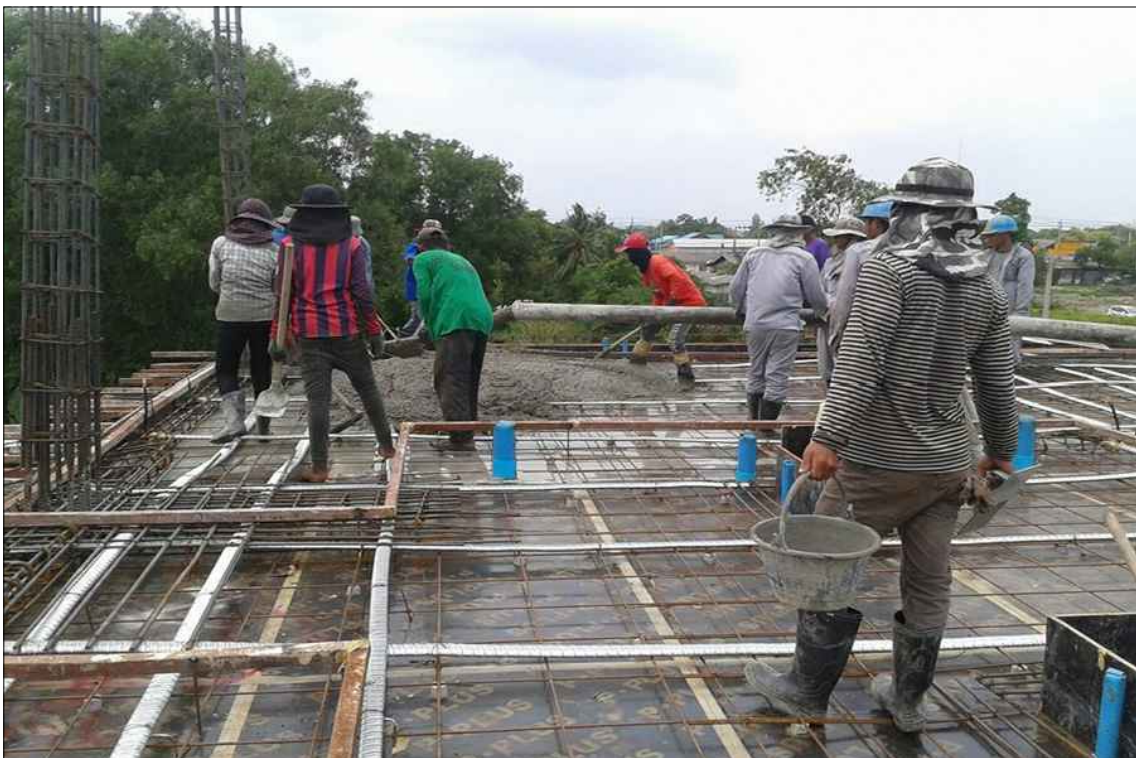
งานโครงสร้างพื้นชั้นที่ 3
