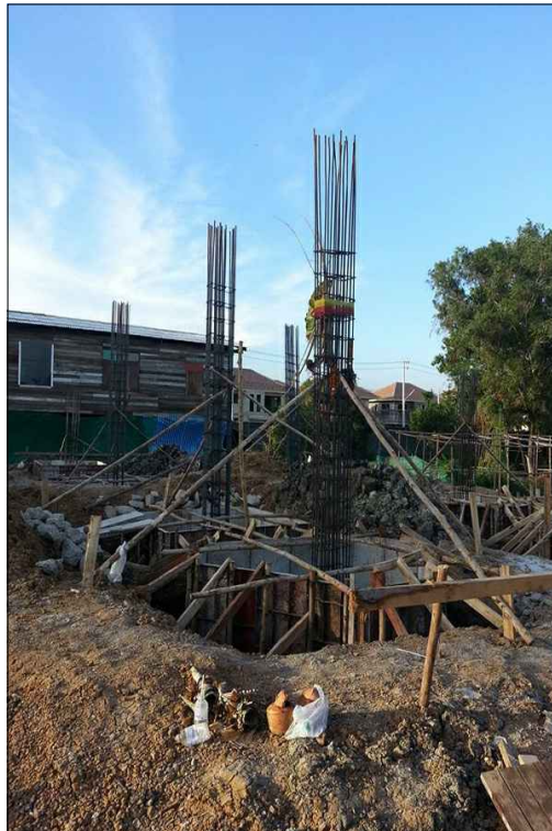
งานตัดหัวเสาเข็มและ งานโครงสร้างฐานราก
