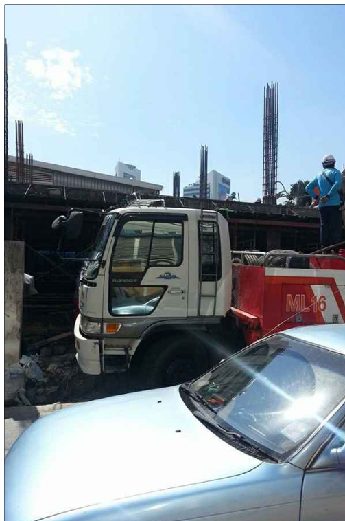
งานเทคอนกรีตระบบพื้น POST-TENSION
