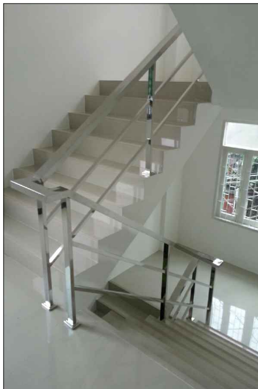
บันไดทางเข้า และ บันไดหลัก
