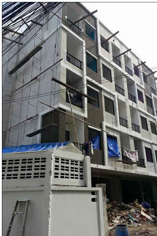
งานทาสีภายนอกอาคาร
