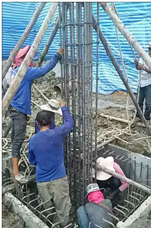
งานโครงสร้างฐานราก
