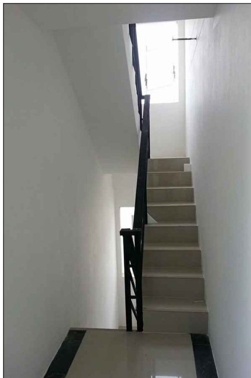
งานตกแต่งบันไดหลักและ บันไดหนีไฟ
